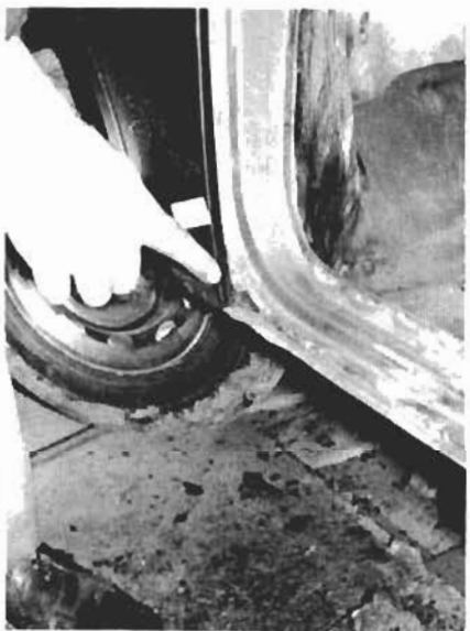
6. Auch an der Unterkante unterscheiden sie sich. Die älteren Bleche sind hier entsprechend der Form des Schwellers nach außen gewölbt.
