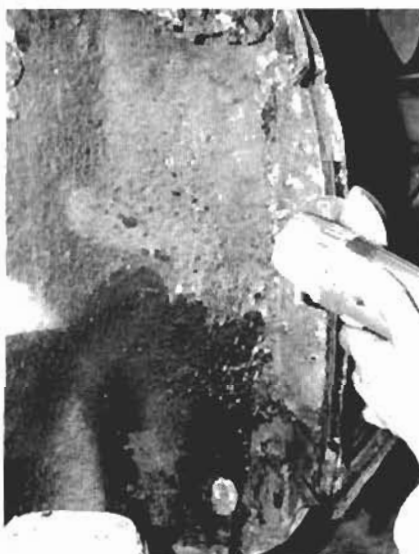
1. Zuerst wird der gesamte Bereich bis auf blankes (bzw. stumpf-braunes) Metall gesäubert, damit das Ausmaß der Schäden deutlich wird.
