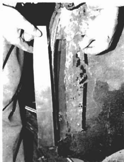
3. Hier wurde das rostige Blech herausgetrennt und ein Reparaturstück zugeschnitten. Das Blech kann überlappend oder stumpf eingeschweißt werden — je nachdem, wieviel Wert man auf sauberes Aussehen in einem relativ versteckten Bereich legt. Denken Sie auch daran, daß eine bündige Passung das Einpassen des A-Blechs wesentlich erleichtert.
