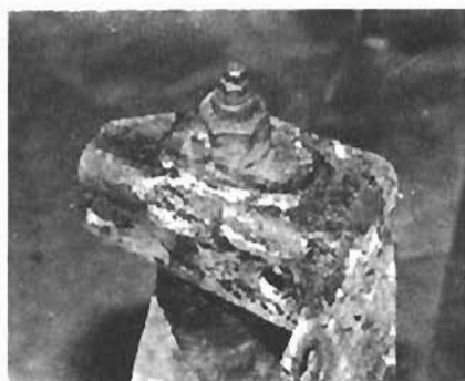
19. Dieser Schmiernippel kann viel zur Verschleißminderung am Schwingarm beitragen. Oft wird er übersehen. Die Lager laufen dann in kürzester Zeit aus.
