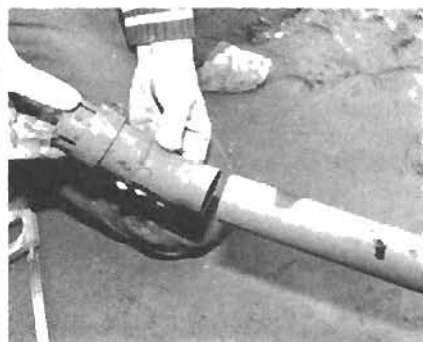
21. ... und das Rohr in den richtigen Winkel gedreht.
