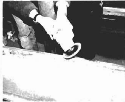
16. Jetzt wäre Gelegenheit, diese normalerweise verdeckten Bereiche zu entrostern — vor allem den Falz, um den die neue Türhaut umgekantet wird. Auch Rostschutzfarbe kann hier nicht schaden.
